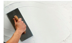
HAND TROWEL DRYWALL FINISH
